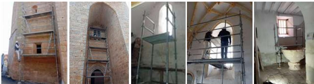
El martes 12 se realizaron catas en las jambas interiores de la ventana O3 y, a la vista de la calidad de las fábricas ocultas bajo los tendidos de yeso, se ordenó el picado de los mismos hasta la arista exterior del caveto que lo enmarca, con apertura de las juntas que se encontraran con sus morteros degradados, cepillado y limpieza de las fábricas. El mismo tratamiento se aplicó en las fábricas exteriores.
